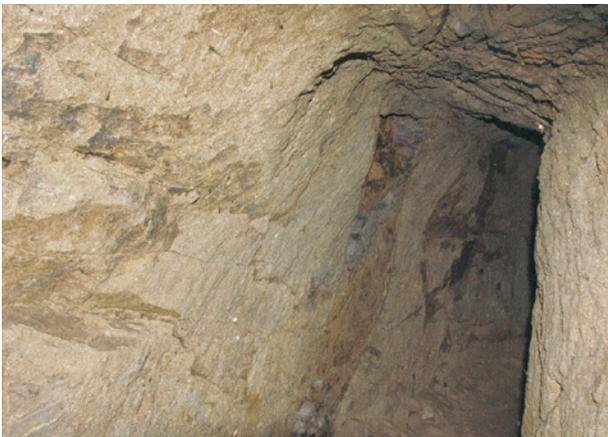
Abb. 70: Profil des Stollens mit Mikrodiorit-/Mikrogabbrogang bei etwa 25 m. Stollenhöhe 1,7m, -breite 0,8 m (Foto: R. Böhme).
