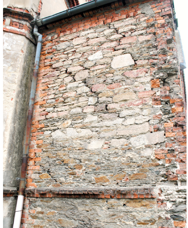
Abb. 21. Mauerwerk der Kirche in Zwickau-Bockwa mit Kohlesandsteinquadern, Bruchsteinen und Ziegeln.
