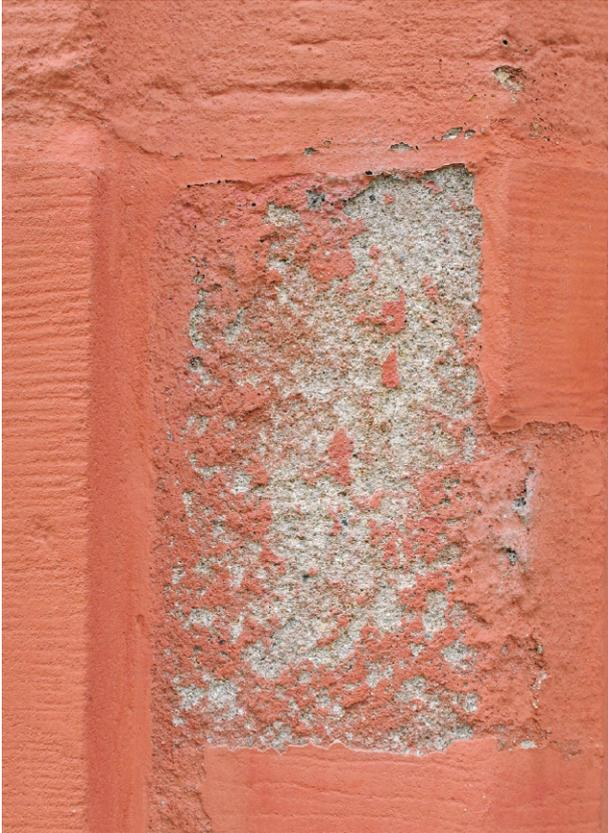
**Abb. 14.** Ablösende Farbschichten auf Sandstein-Oberflächen, Priesterhäuser in Zwickau.
