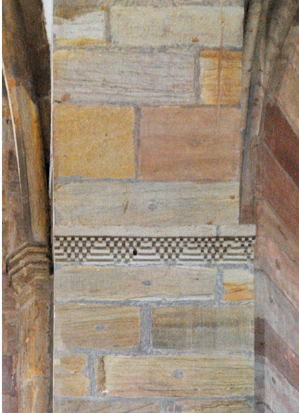
Abb. 15. Kämpfer mit Schachbrettmuster aus Kohlesandstein aus dem romanischen Vorgängerbau der Katharinenkirche in Zwickau (um 1200).
