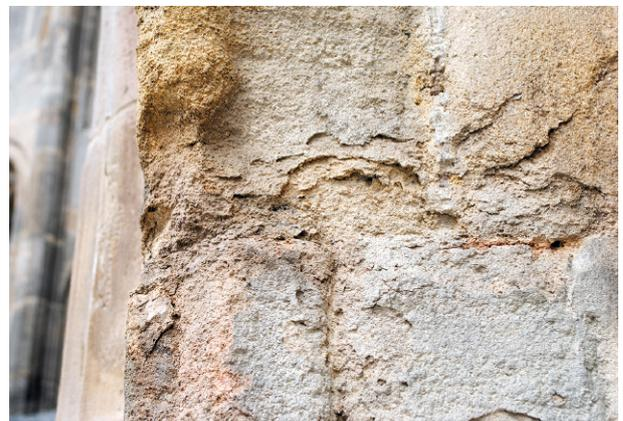
**Abb. 13.** Gipskrusten auf der Sandsteinoberfläche verursachen dahinter liegende Mürbzonen und Materialverluste.
