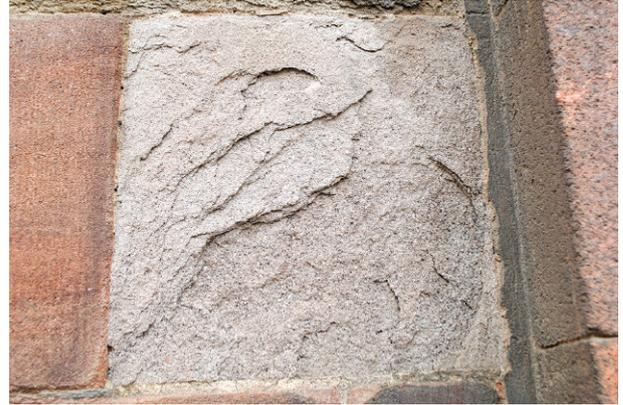
**Abb. 11.** Schuppen- und Schalenbildung an einem nicht lagergerecht eingebauten Werksteinblock, Katharinenkirche Zwickau.
