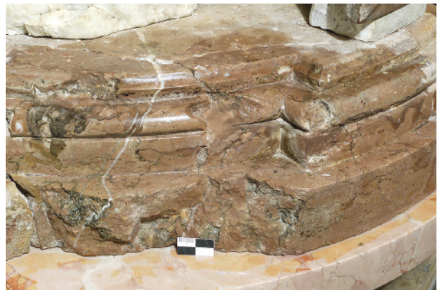
Abb. 17. Roter Knollenkalk, wahrscheinlich von Grünau bei Wildenfels, in der Sockelplatte des Taufsteins (angefeuchtet; Foto: D. Krause).
