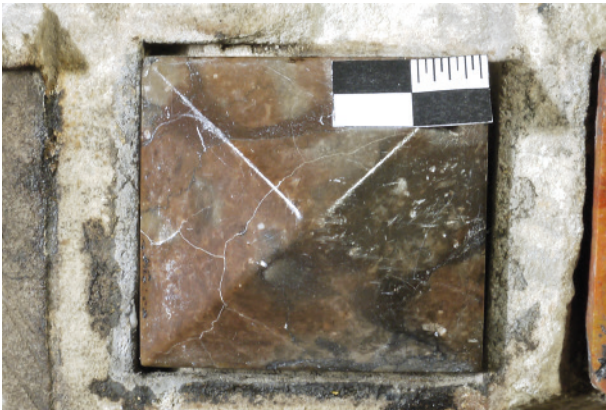
Abb. 19. Diamantquader aus rotem Kalkstein im Fries (angefeuchtet; Foto: D. Krause).
