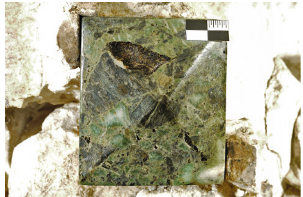
Abb. 24. Diamantquader aus Serpentinitlekzie Verde Antico am Fuß des Taufsteins (angefeuchtet; Foto: D. Krause).
