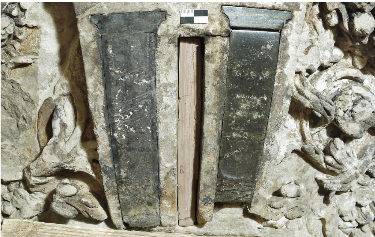
Abb. 8. Einlagen aus Zöblitzer Serpentin und hellem Kalkstein in der Ausladung unter dem Taufbecken (Foto: D. Krause).
