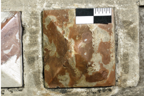
Abb. 21. Diamantquader aus rot-weißem, fossilhaltigem Kalkstein im Fries (angefeuchtet; Foto: D. Krause).
