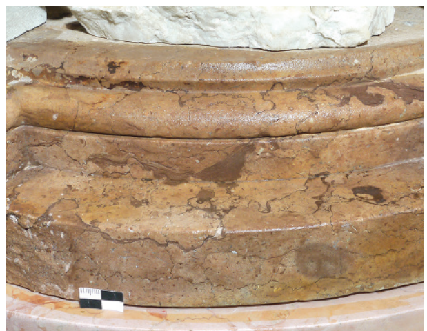
Abb. 18. Roter Knollenkalk, wahrscheinlich von Grünau bei Wildenfels, in der Sockelplatte des Taufsteins (angefeuchtet; Foto: D. Krause).
