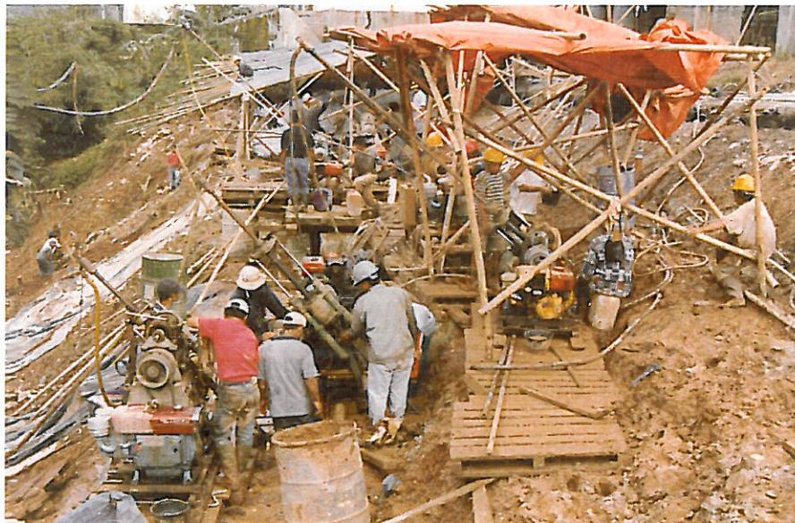
**Abb. 3: Bohrarbeiten für die Rückverankerung der Spritzbetonsicherung**
