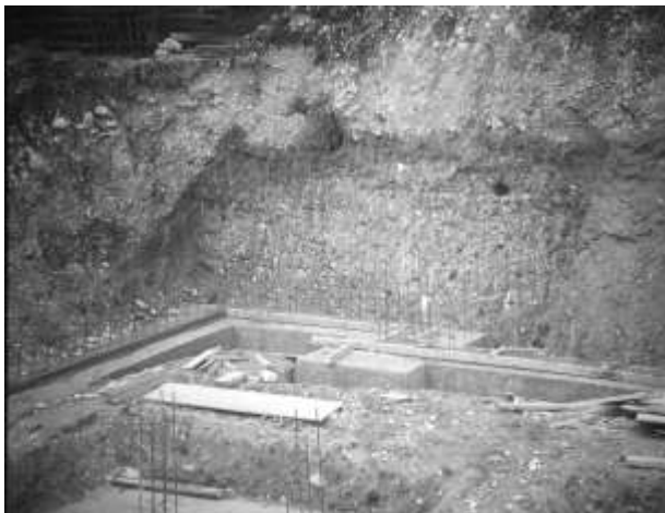
Abb. 9: Ehemalige Baugrube der Krankenhaus Bad Aussee. Gut ist die liegende Grundmoräne der Riß-Eiszeit über dem Streifenfundament zu erkennen, die von der sandigen, dunkleren Verwitterungszone bedeckt ist. Im Hangenden die groben Schotter aus dem Beginn des Würm Hochglazials.
