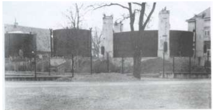
Gasbrunnen im Allgemeinen Krankenhaus Wels (1939)
