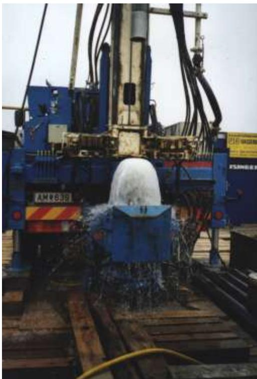
Abb. 7: Wasseraustritt infolge eines „Gas Lifts“ im Zuge der Bohrung.
