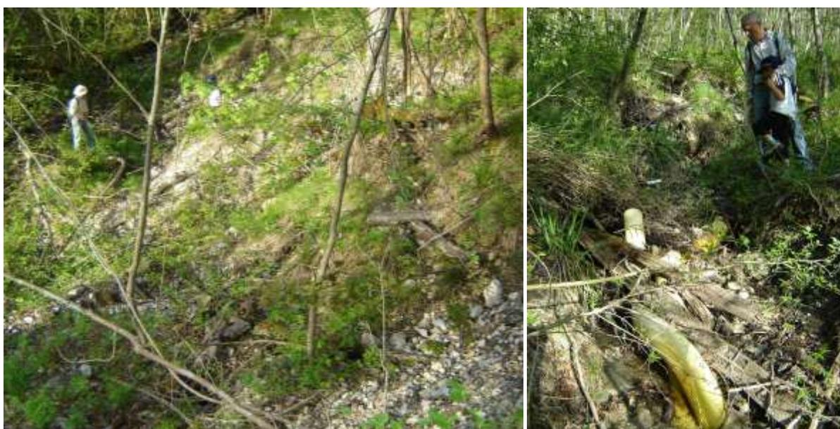
Abb. 7a, b: Rutschung durch Wasserinfiltration an einer für den Drainagerohreinbau neu angelegten Stichstraße (links); Nicht mehr funktionelle und völlig zerstörte Drainagerohre (rechts) im aktiven Bereich des Gschlifgrabens (Foto: J.T. Weidinger/W. Vortisch 2005).
