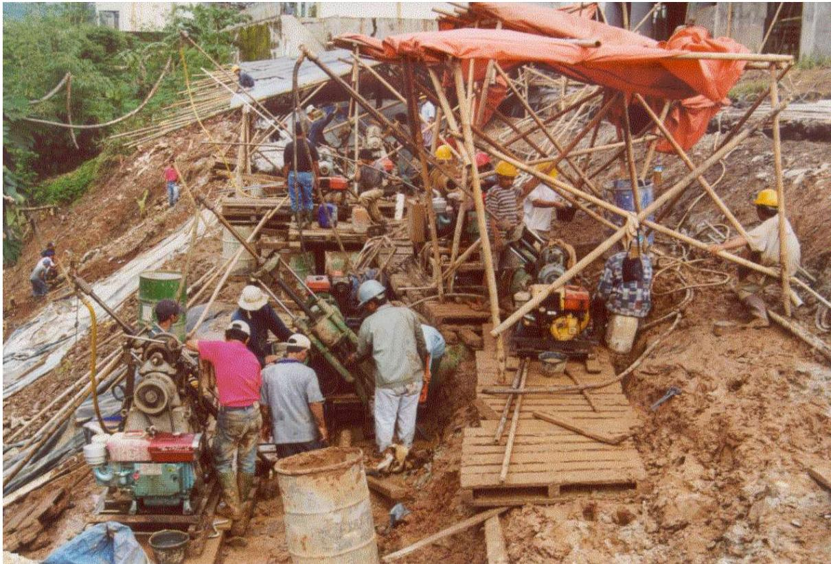
Abb. 3: Herstellen von Ankerbohrungen
