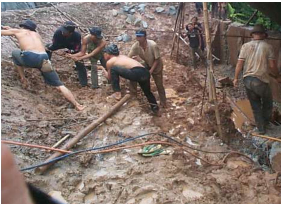
Abb. 2: Baustellenbetrieb bei ungünstigen Witterungsverhältnissen
