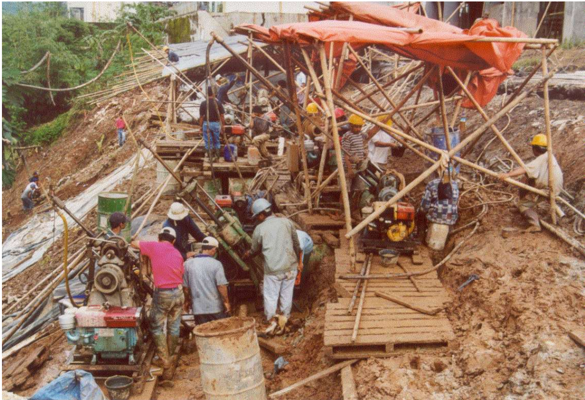
Abb. 3: Herstellen von Ankerbohrungen
