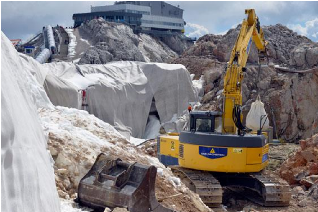
Abb. 6: Baustelle Eispalast im Sommer 2012.
