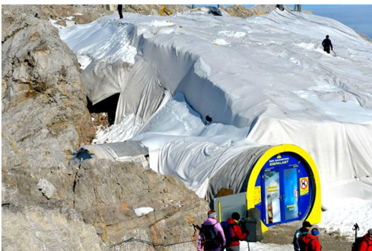
Abb. 4: Gletschersituation am Eispalast 29. 08. 2012. Mit Abdeckplanen die jedes Jahr größer werden, versucht man den Eispalast vor dem Wegschmelzen zu retten. Der Neuschnee strapaziert die Planen und erhöht den Druck auf die Decke des Eispalastes.
