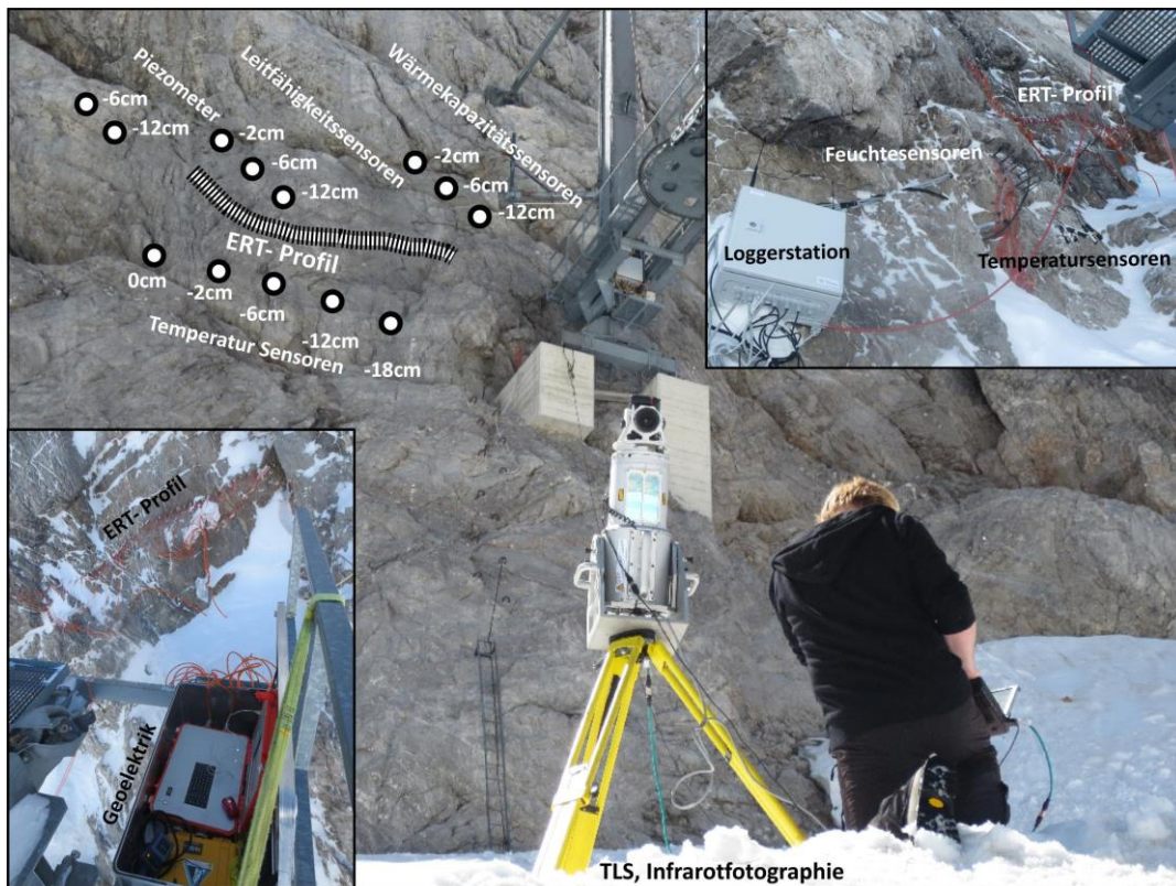
Abb.2: Monitoring Station des ROCKING ALPS Projekts in der Nordwand des Koppenskarsteins auf der Säule des Austriaschartelifts (Fotos: Rode M. 2012).
