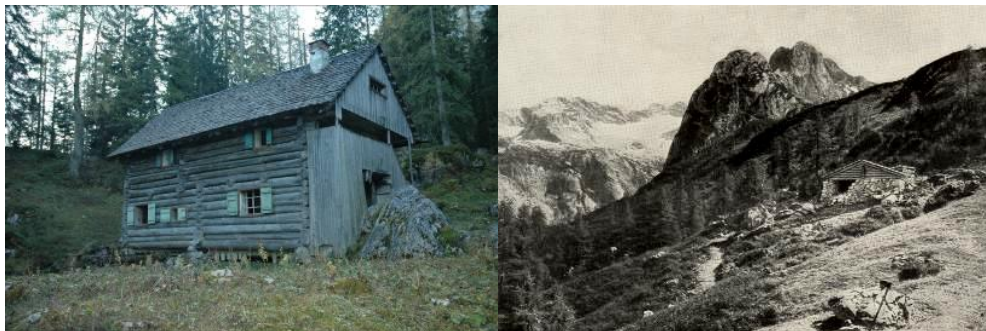
Links: Alte baufällige Doppelhütte Vord. Scharwandalm
