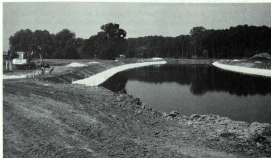
Foto 8: Thaya-Regulierung, Anlage eines Durchstiches im Sommer 1982 zwischen Rabensburg und Bernhardsthal.
