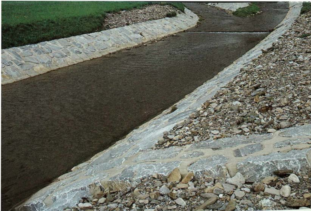
Foto 1: Betonkorsett als Antwort auf ein Katastrophenhochwasser im Oberlauf der Raab. Foto 2: Störsteine als fischereiliche Mindestforderung an der regulierten Lafnitz.
