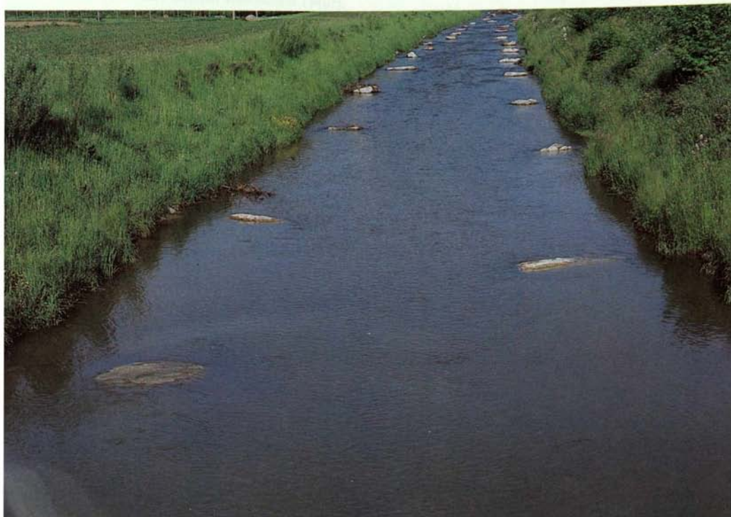
Foto 1: Betonkorsett als Antwort auf ein Katastrophenhochwasser im Oberlauf der Raab. Foto 2: Störsteine als fischereiliche Mindestforderung an der regulierten Lafnitz.
