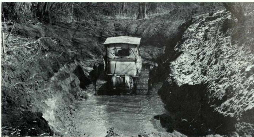
Foto 21: Altarmvertiefung im Zuge des Sanierungsprojektes „Altarm bei Rohr“.
