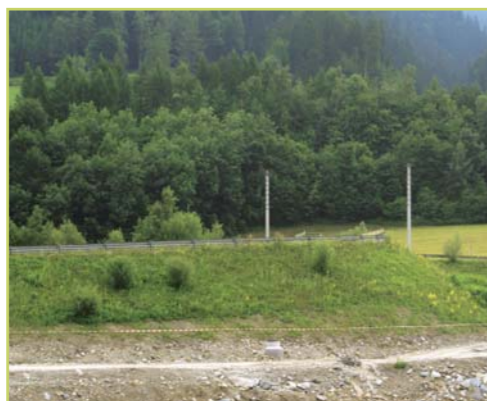
Die Straßenböschung mit dem wertvollen Halbtrockenrasen. C.A.
