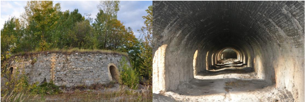
Abb. 1: Ringofen bei Förderstedt (links: Außenansicht, rechts: Innenansicht)
