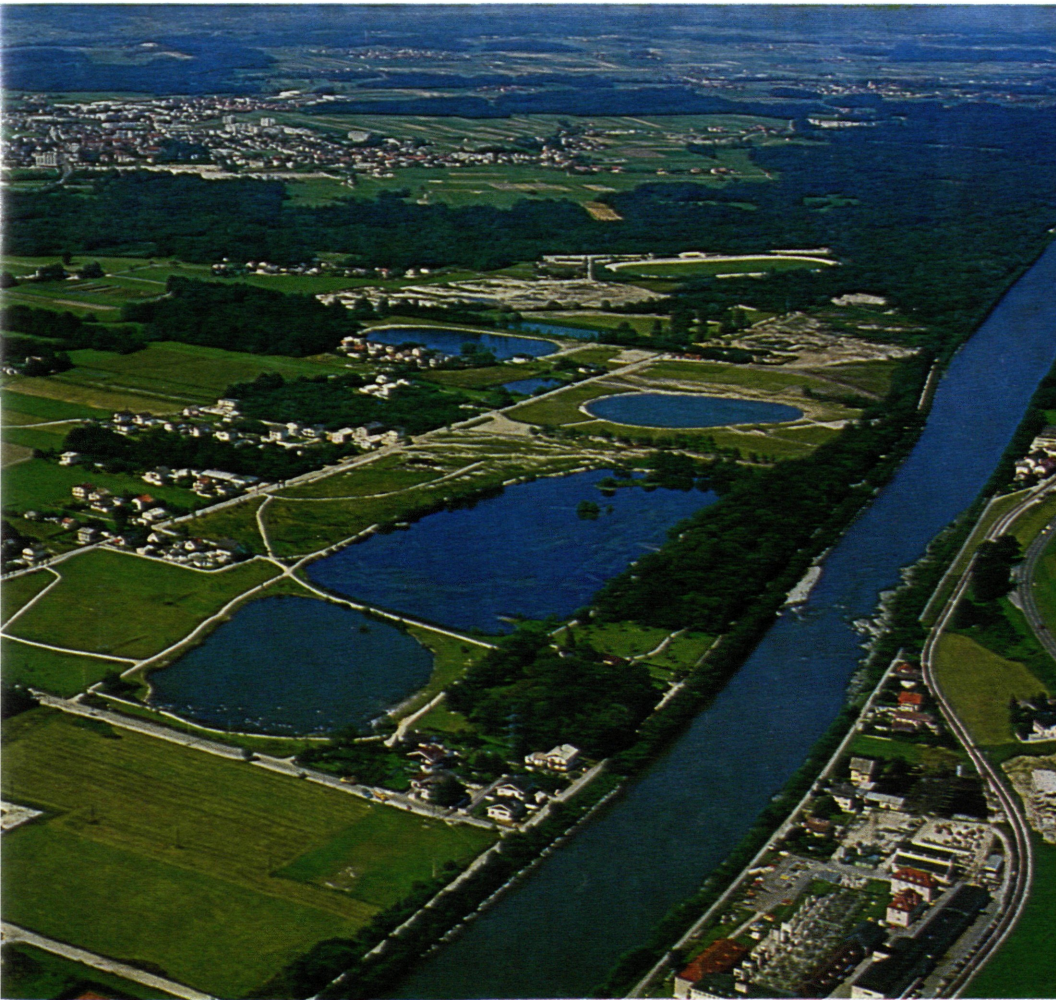
Luftbild freigegeben vom BMfLV, Zl. 11197 RAbtB/74
