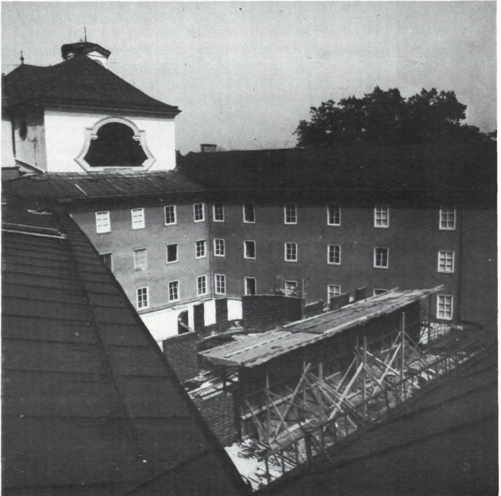
Der Erweiterungsbau in dem bereits ebenerdig verbauten Innenhof.
