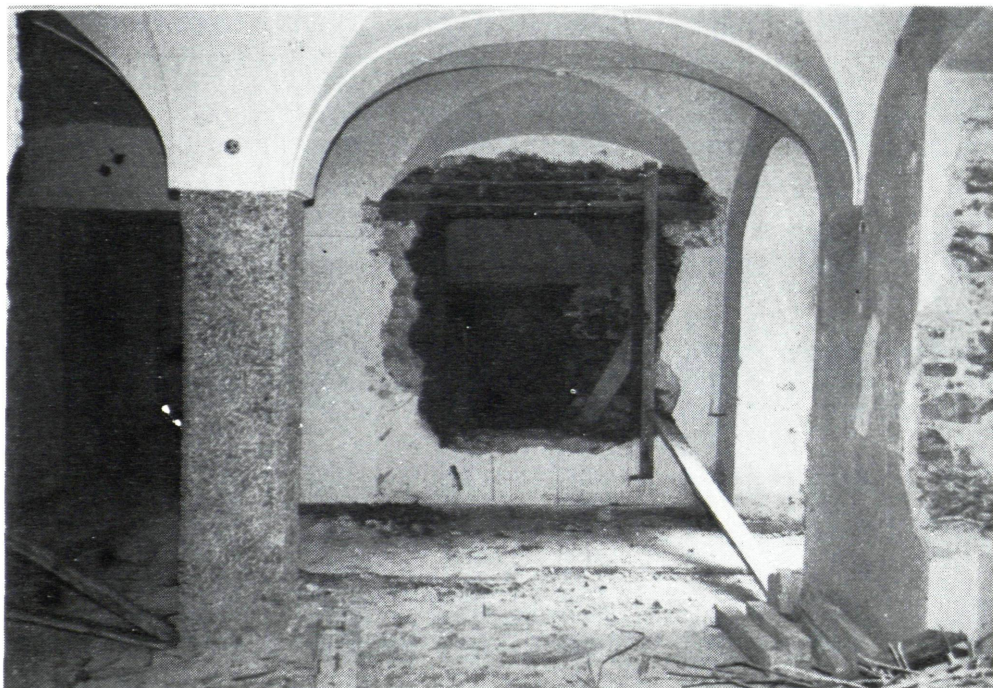
Die ersten Bauarbeiten im Großaquarium
