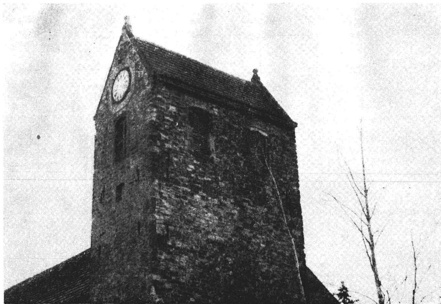
Abb. 4. Oberteil des Turmes der Bricciuskirche in Halle-Trotha
