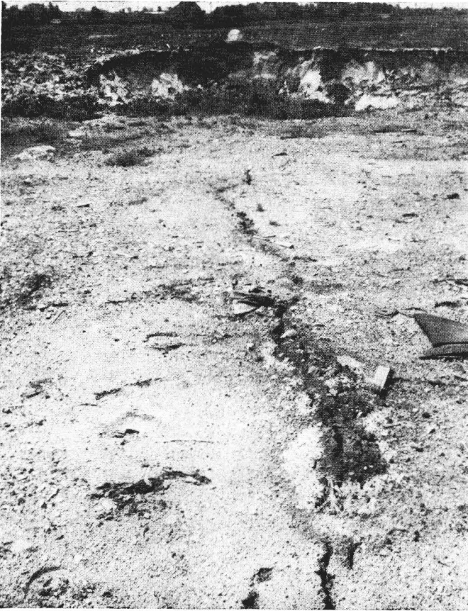
Abb. 1. Teilansicht einer Deponie. Im Vordergrund Rißbildung mit Gasaustritten und Erhebungen. Schwarze und weiße Zonen deuten auf Schwefelsäure-, Salz(Sulfat)- und Schwefelbildung hin
