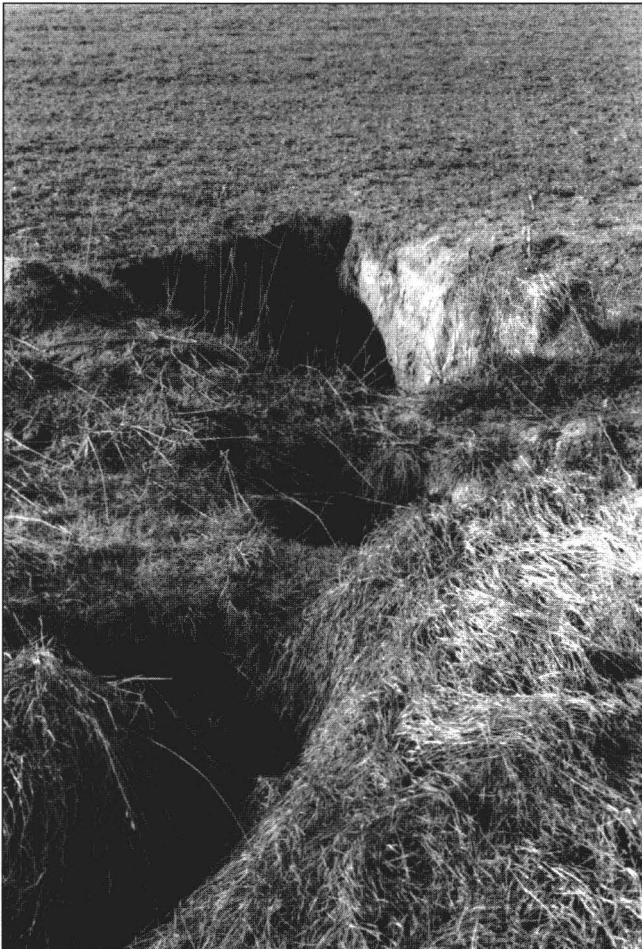
Abb. 4 Eingestürzte Tunneldecke im Löß
