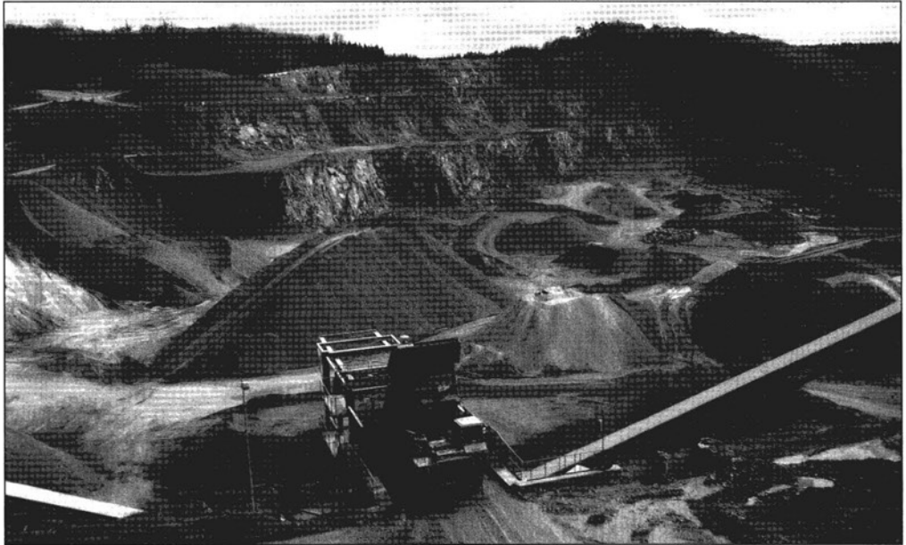
Abb. 6: Überblick über den Steintagebau Rieder
