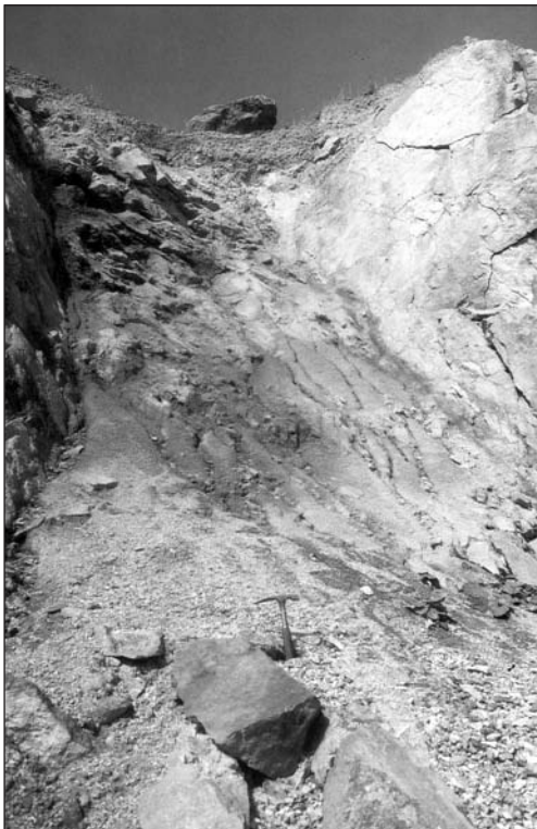
Abb. 20 Stark verwitterter Bereich; 2. Sohle, W
