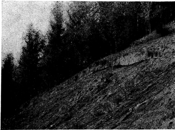
Abb. 1. Zu dünner Löß-Auftrag über kulturfeindlichem tertiärem Material ist abgerutscht (Hochkippe zwischen Nachterstedt-Frose)
