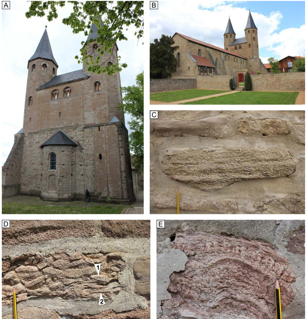
Abb. 13 Klosteranlage Drübeck und dessen typische Bausteine der unverputzten Mauerwerke. A) Westwerk mit weithin sichtbaren Türmen der Klosterkirche St. Vitus. B) Rückseitige Ansicht der flachgedeckten Basilika St. Vitus mit Klostersgarten (Garten der Stiftsdamen) im Vordergrund. C) Oolith mit bimodaler Verteilung der Ooid-Durchmesser als Baustein mit bis zu 3 mm großen Ooiden. D) Stromatolithisch umkrustete Ooid-Intraklasten (1) und stromatolithische Krusten (2) als Baustein. E) Kissenförmiger Stromatolith als ungewöhnlicher Baustein, meist wurden die Stromatolithe für Mauerwerke nicht verwendet.
