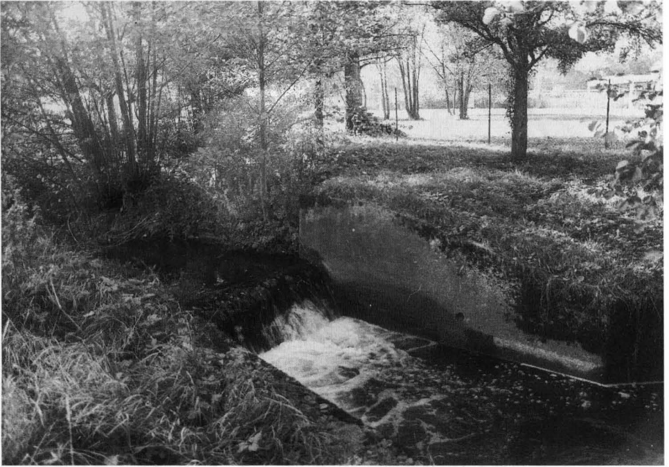
Abb. 2. Querbauwerk im Biebertverlauf unterhalb der Ortschaft Biebergemünd-Kassel. Die Bieber ist an dieser Stelle ca. 0,6 m tief und 3–4 m breit, die Sohlschwelle hat eine Fallhöhe von 0,6 m (bei mittlerem Wasserstand).
