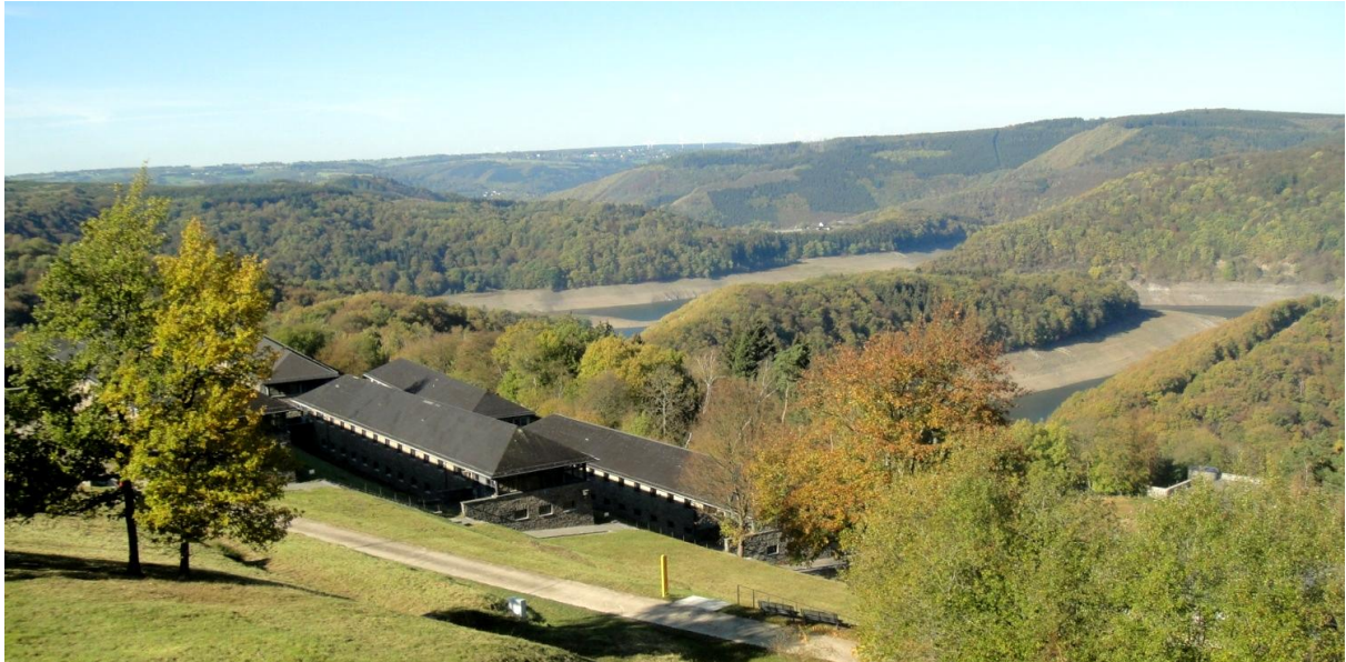
Abb 1: Blick von der Besucherterrasse der "Ordensburg" Vogelsang (Teil der ehem. Mannschaftsgebäude) auf die im Herbst 2011 extrem leere Urfttalsperre und den Kermeter (Foto H.J. HOFFMANN)
