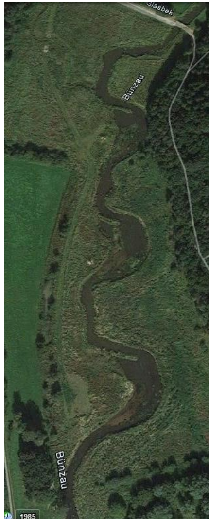
Abb. 2: Bünzener Au mit künstlich angelegten Schleifen und Flachwasserzonen (Google Earth, Bildaufnahmedatum: 09.12.2016)
