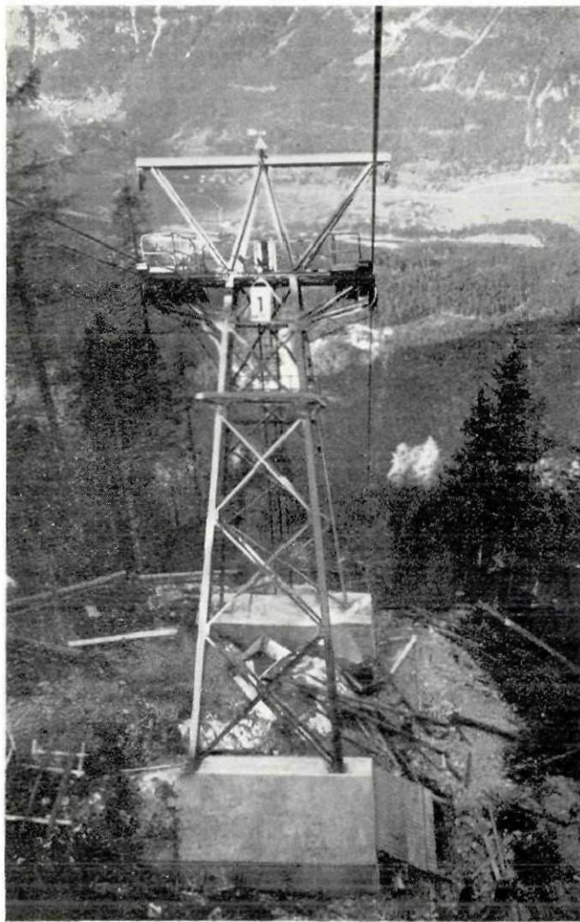
Der einzige Mast der Dachstein-Seilbahn mit Blick auf den Hallstätter See
