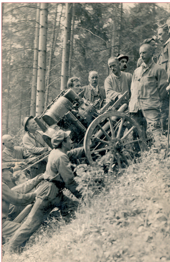
Abb. 2: Aufzug der benzinbetriebenen Lichtmaschine zum Eingang der Rettenwandhöhle.
