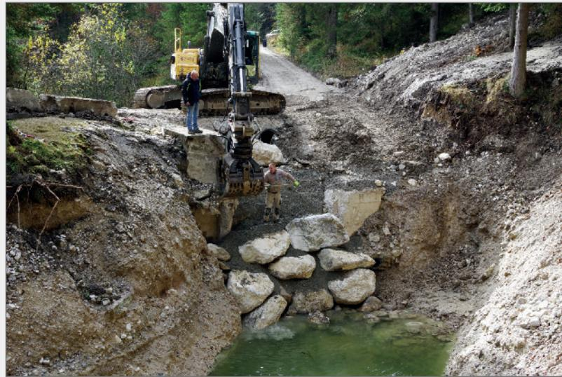
Abb. 14: Für den neuen Überlauf des Quelltopfes musste eine Steinschichtung mit Betonhinterfüllung aufgebaut werden. Foto: Robert Seebacher
