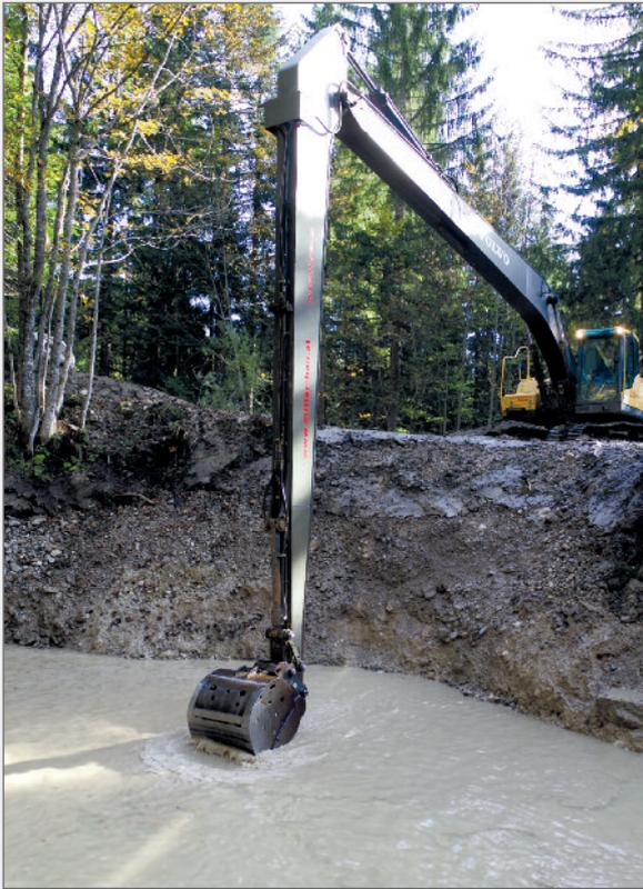
Abb. 13: Mit dem Spezialbagger wurde der Quelltopf bis in 10 m Tiefe freigelegt. Foto: Robert Seebacher
