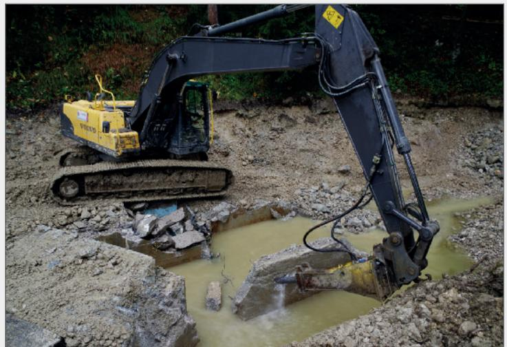
Abb. 12: Abbruch der Quellkammer mit einem schweren Hydraulikhammer. Foto: Robert Seebacher
