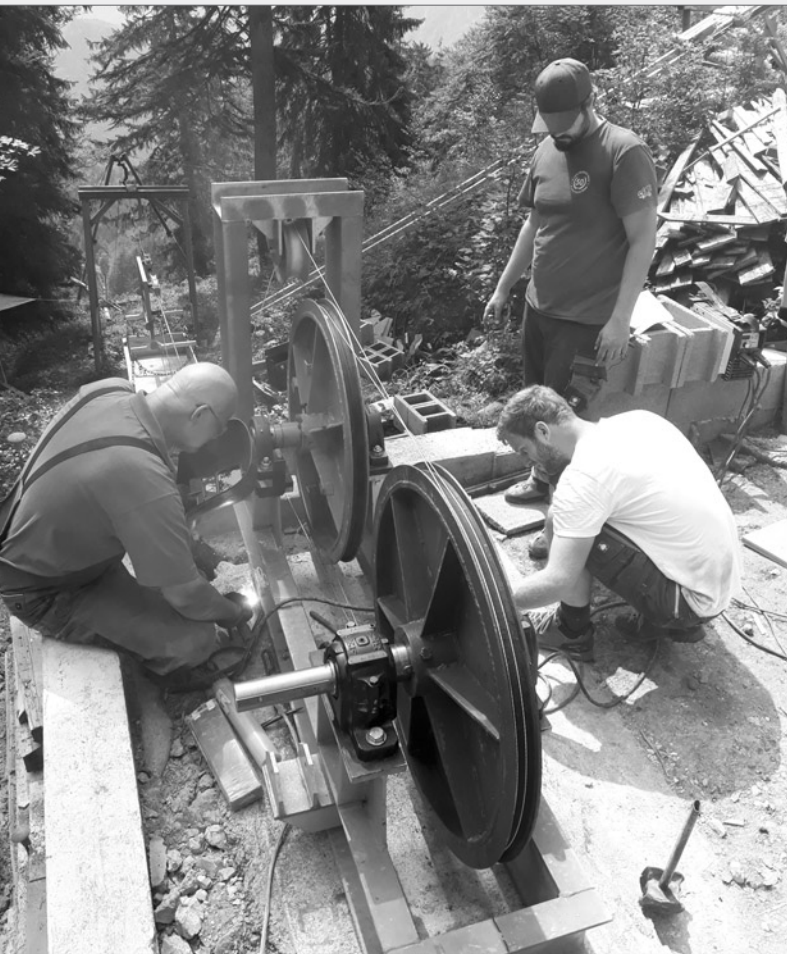
Installation des Seilbahnantriebs.
