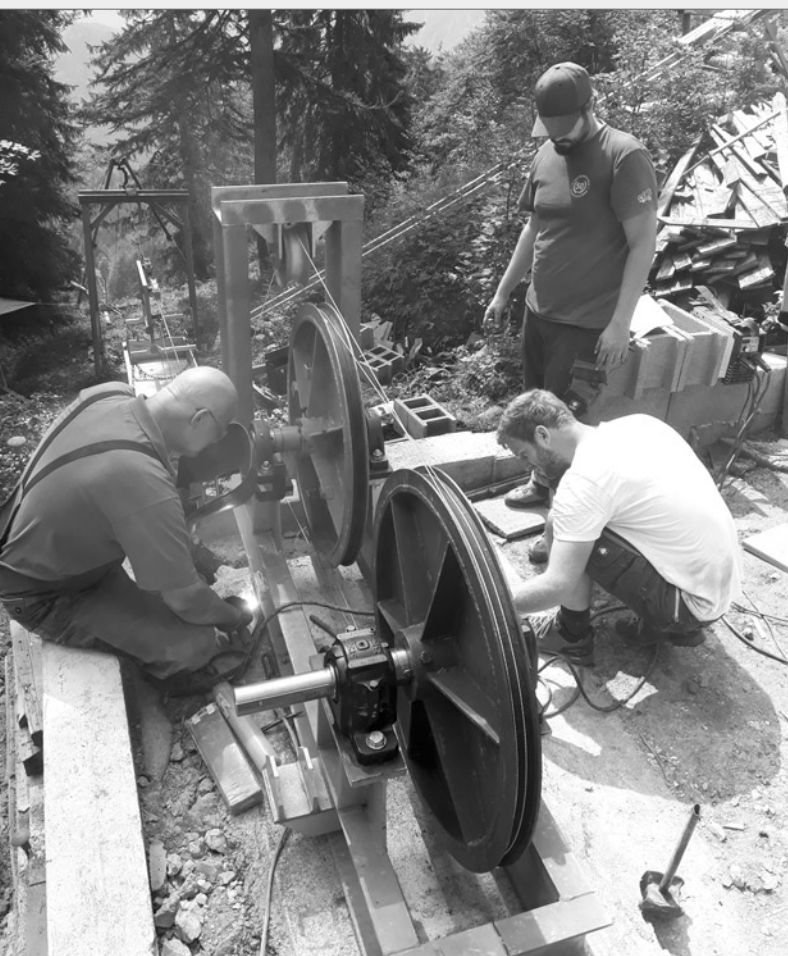
Installation des Seilbahnantriebs.
