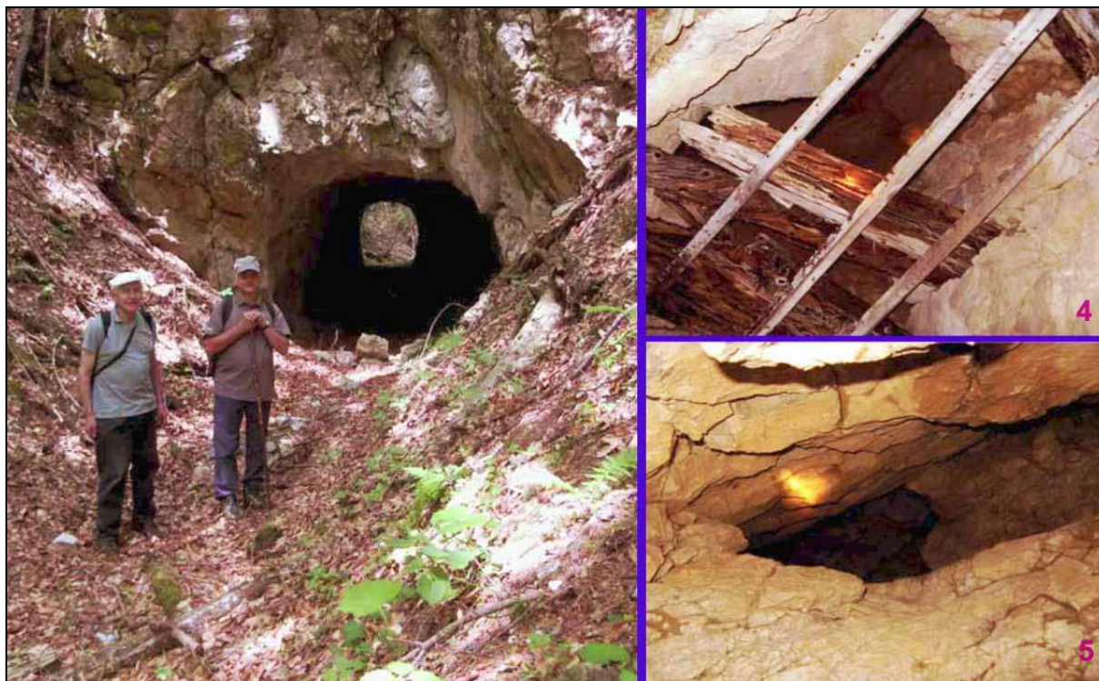
Abb. 3: Alter Waldbahntunnel. Foto: G. PLANTEU
