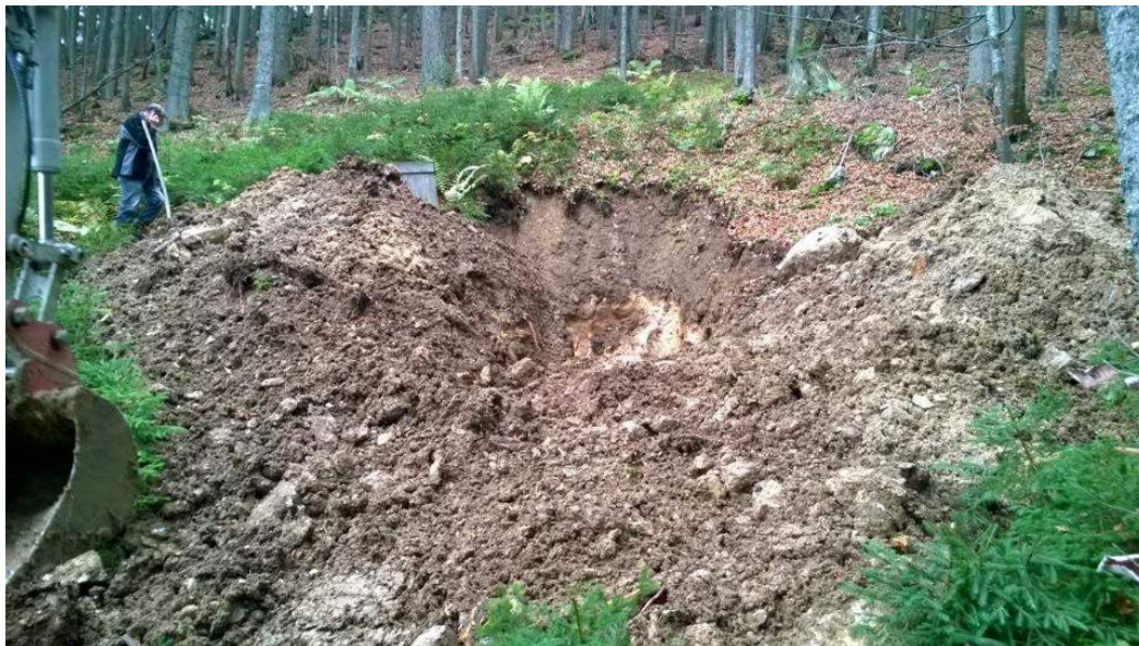
Öffnung des Stollenmundloches 29.10.2015, Foto: Harald LANGER
