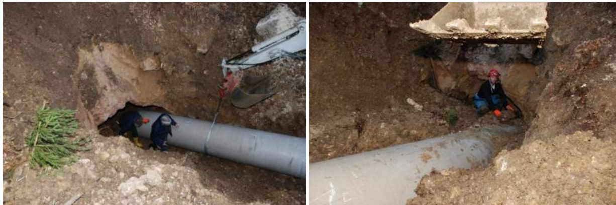
Rohreinpassung und Aufschlichtung im Bereich des Mundloches zur Deckenabstützung Fotos: Andreas LANGER
