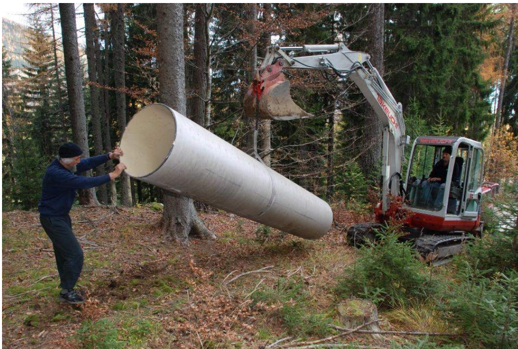
Rohrtransport zum Eingang, Foto: Andreas LANGER
