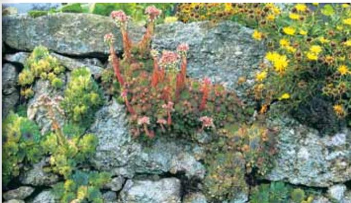
zusammenhalten. Bei derartigen Trockenmauern ist ein Betonfundament bis in frostfreie Tiefe nicht erforderlich.
