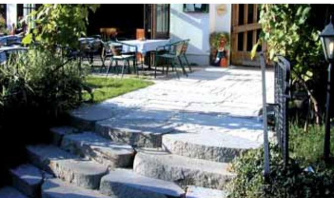
Stiege aus Findlingsblockstufen aus Granit mit anschließendem Weg aus Granitkrustenplatten.
