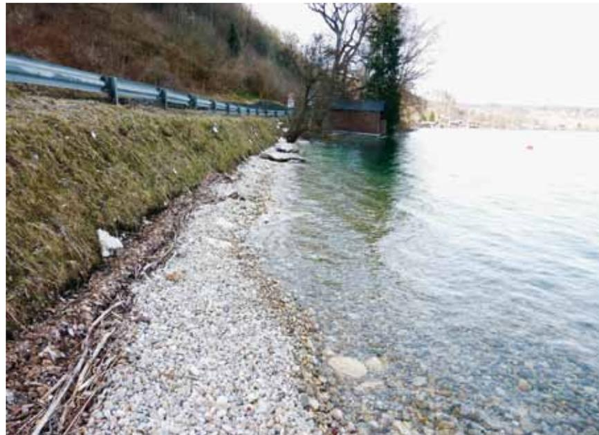
forderliche Seefläche auf ein Minimum zu reduzieren. Anstatt einer 2 m hohen Steinschichtung mit einem Böschungswinkel von 1:1 wurden im Bereich der Mittelwasseranschlagslinie mehrere, flache und unregelmäßige Blockreihen gesetzt und mit autochthonem Schottermaterial überschüttet. Dazwischen wurden Wurzelstöcke verankert. Der Maueraufbau wurde steil gestaltet, mit Schotter und Humus überschüttet und mit Weidenstecklingen bepflanzt.
