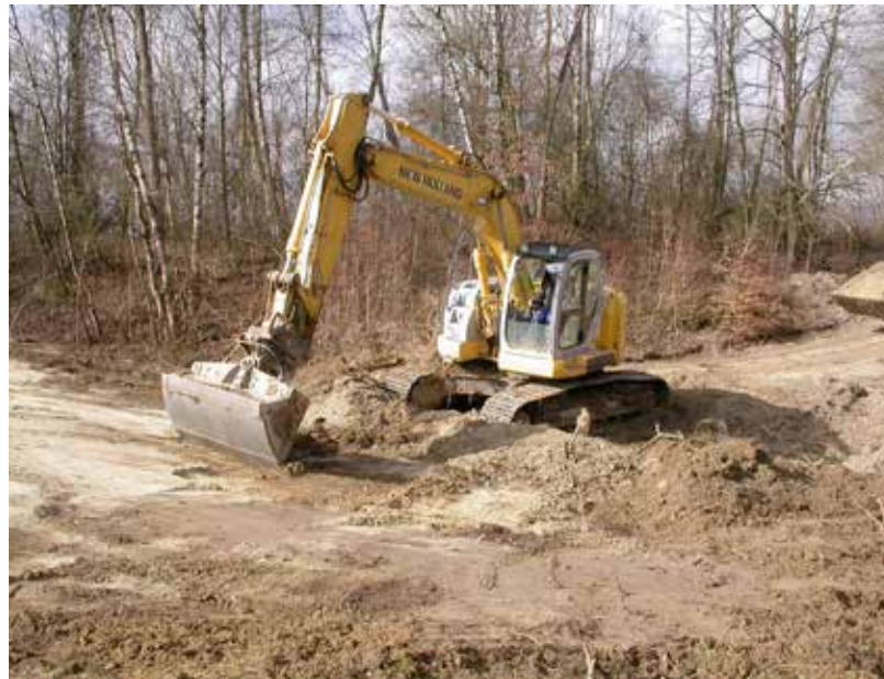
Der Bagger entfernt die oberste Bodenschicht, um Nistplätze für Wildbienen zu schaffen.
