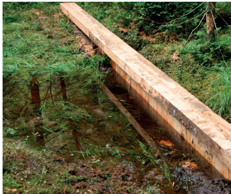
Die Stauwirkung ist schon kurze Zeit nach Errichtung des Dammes erkennbar. (Abb. 3)
