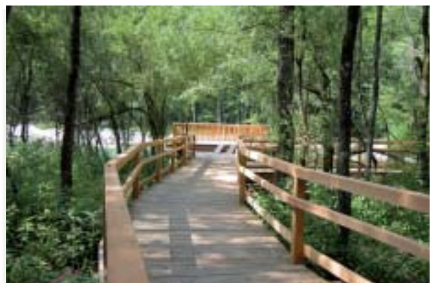
Der Lärchensteg durch die Hartholzau in die Silberweidenau soll behindertengerecht ausgeführt werden, zwei Beobachtungsplattformen am Ennsufer miteinbinden und schließlich in einen schmalen Waldpfad am Ennsufer münden, der durch schattigen Mischwald ...
