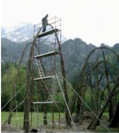
Baustelle in luftiger Höhe
