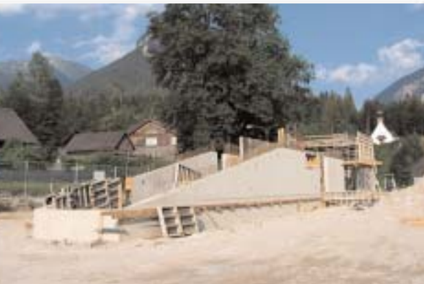
Die Grundmauern des Pavillons in Gstatterboden
