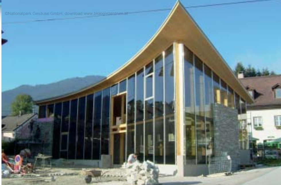
Der Rohbau des Infobüros im September
