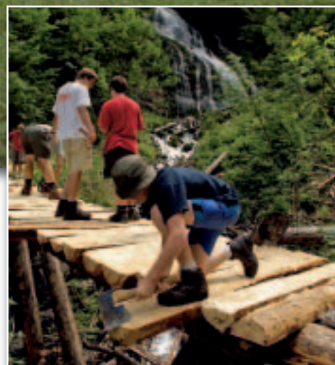
Wahrlich eine Europabrücke: Acht Nationen waren am Stegbau im Hartelsgraben beteiligt
