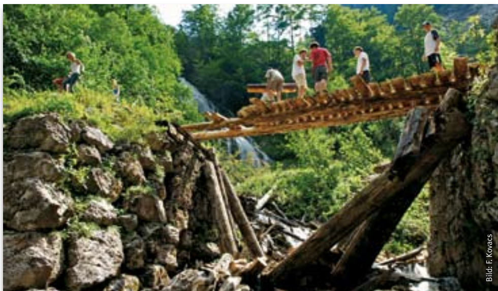
Junior Ranger beim Bau der Fußgänger-Brücke über den Hartelsgraben
