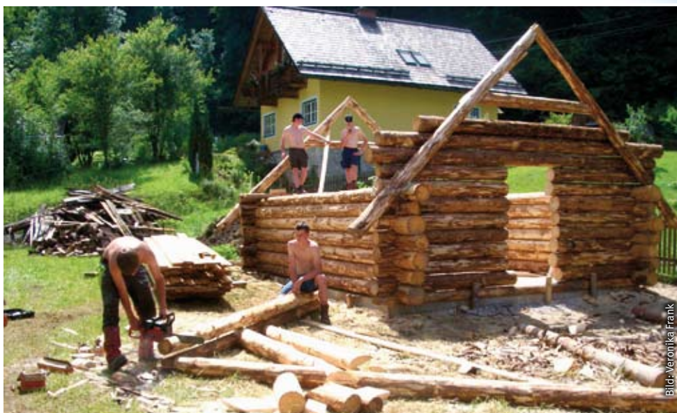
Die Wände stehen bereits.
