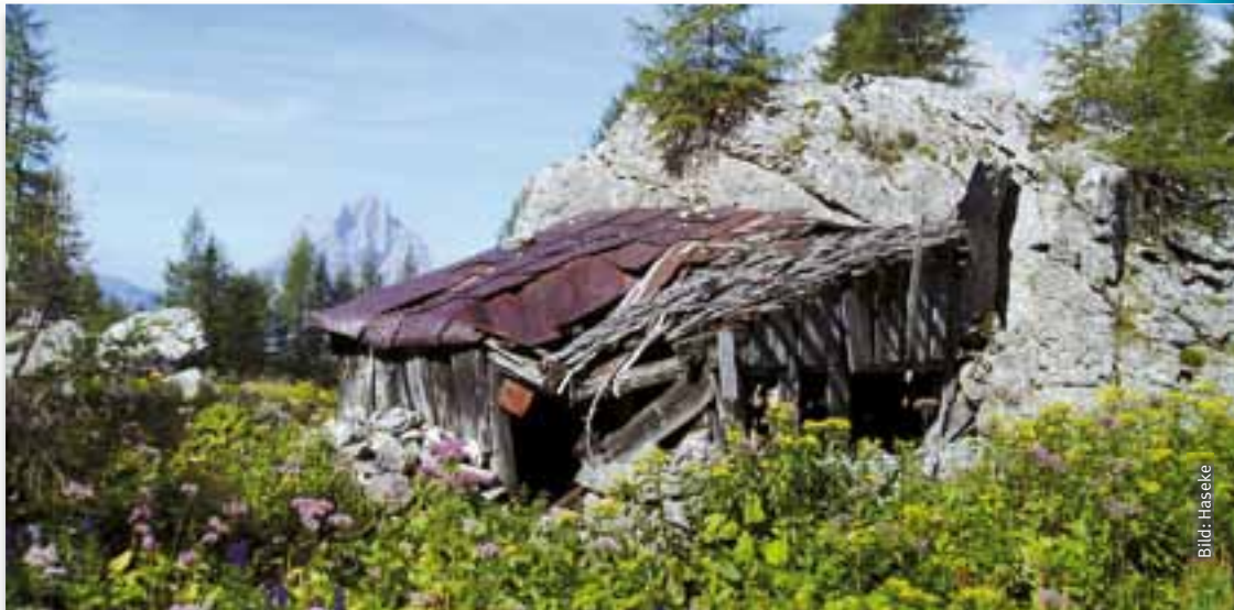
Endstation. Diese Almhütte ist wohl nicht mehr zu retten – Unteres Stadelfeld
