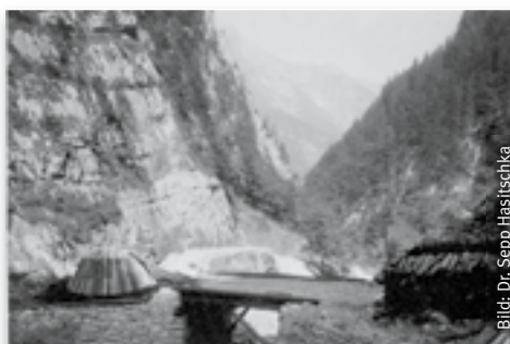
Rundmeiler an der Hochreith-Brücke
