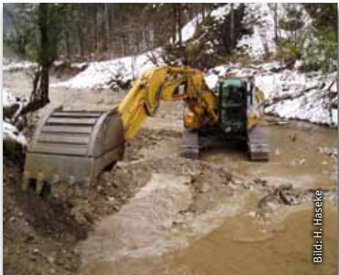
Hier wurde der Wildbach Schritt für Schritt wieder seinem Naturzustand angenähert.
