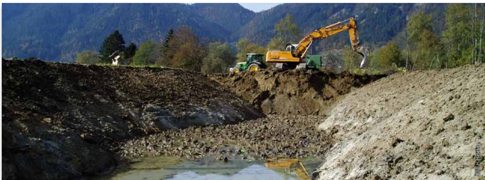
Baggerung eines neuen Flussarmes im Oktober 2006. Insgesamt wurden über 30.000 Kubikmeter Erdreich bewegt.
