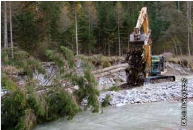
Wir haben daher bis zuletzt nachgebessert und fixierte Bäume in den Bach gesetzt, damit sich das Geschiebe sammeln kann.
