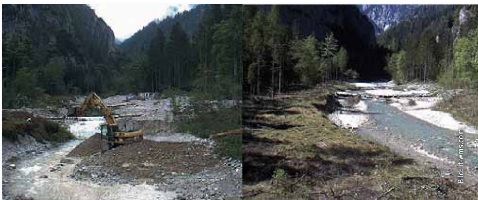
Aufnahmen von unserer Monitoring Webcam am Johnsbach aus dem Jahr 2007 während der Bauphase und 2011.
