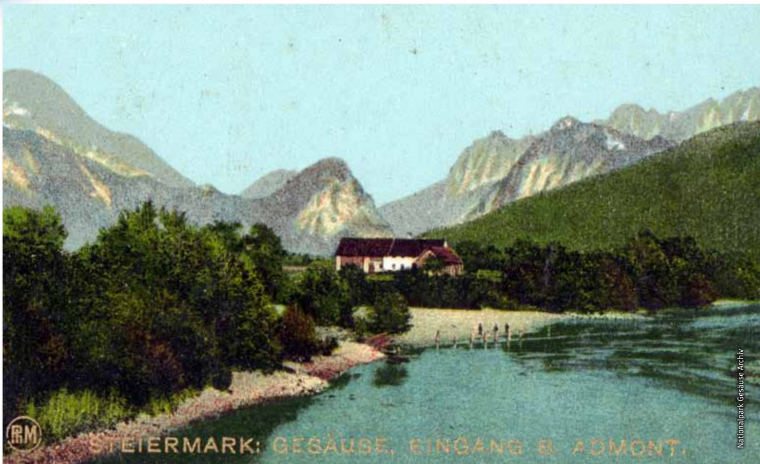
Die für Fische unüberwindbare Stufe wird im Rahmen des LIFE+ Projektes „Flußlandschaft Enns“ wieder rückgebaut.
