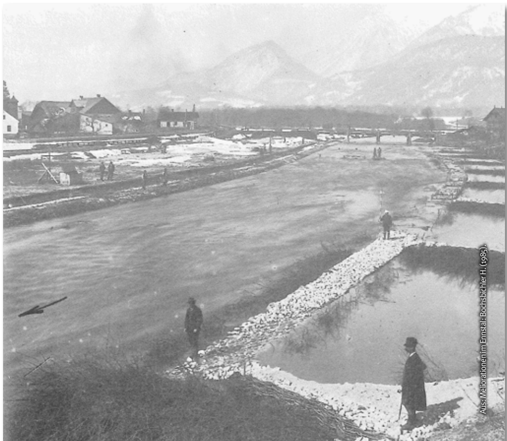
Darstellung von frisch errichteten Bühnenfeldern in der neu entwickelten „Buschbauweise“.
