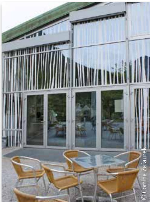
Dank der „Zebrastrifen“ fliegen keine Vögel mehr gegen die Glasfassade.
