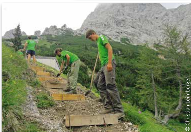
Steile Wegpassagen werden mit Stufen entschärft
