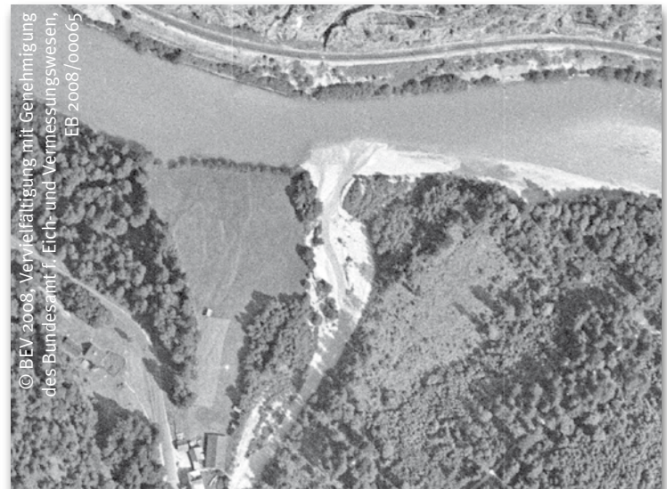
Das Luftbild von 1954 mit der Situation im Bereich der Johnsbachmündung und der Straßenquerung beim Gasthaus Bachbrücke.
