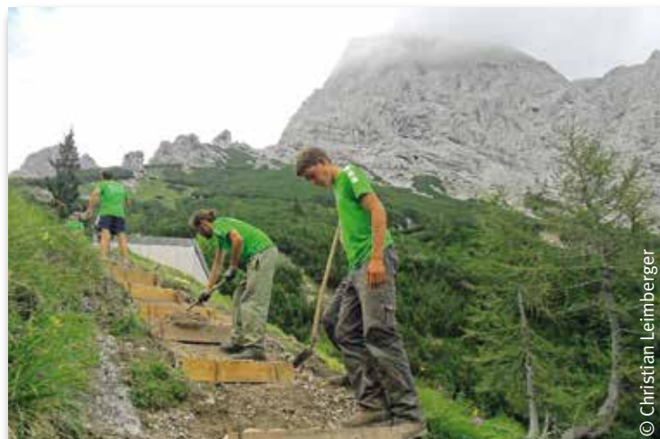
in mühsamer Arbeit wird Stufe um Stufe gebaut
