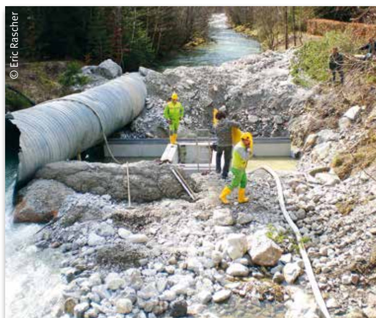
Mitarbeiter der BOKU und der WLW bauen im März 2014 die Geschiebefalle mit vorgelagerter Geophonanlage in Höhe des Gasthofes zur Bachbrücke ein.
