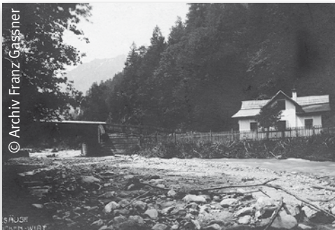
Die Brückenquerung über den Johnsbach im Bereich hinter dem heutigen Gasthaus „Bachbrücke“.
