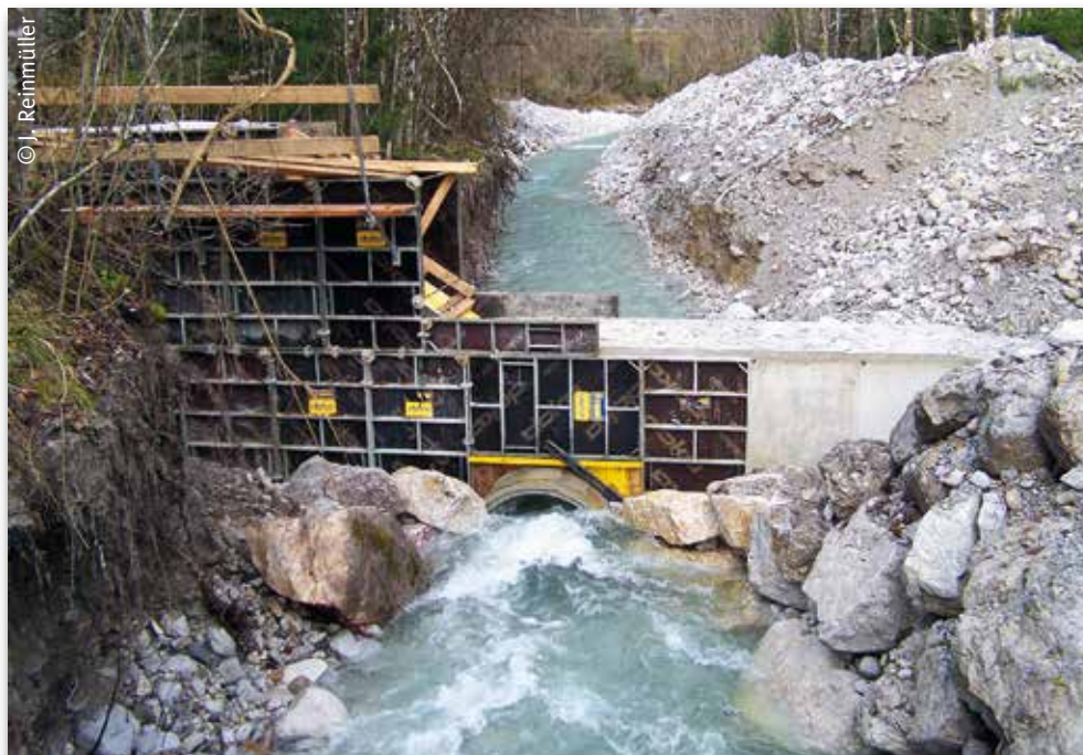
Der Bau einer Betongrundschwelle (oben) und nach Fertigstellung (unten) – Die Grundschwelle ist völlig im Gewässerbett verschwunden.
