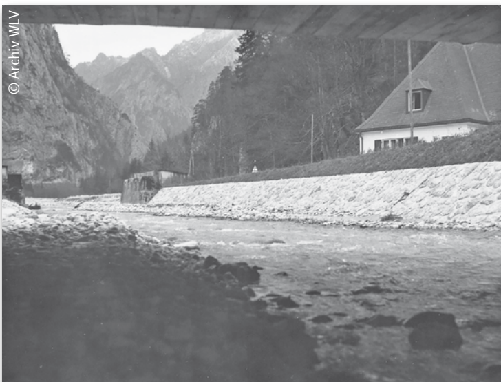
Bild von der neuen Brücke über den Johnsbach und der Längsverbauung beim neuen Gasthaus Bachbrücke (im Hintergrund sind noch die Fundamente der alten Brücke zu sehen).
