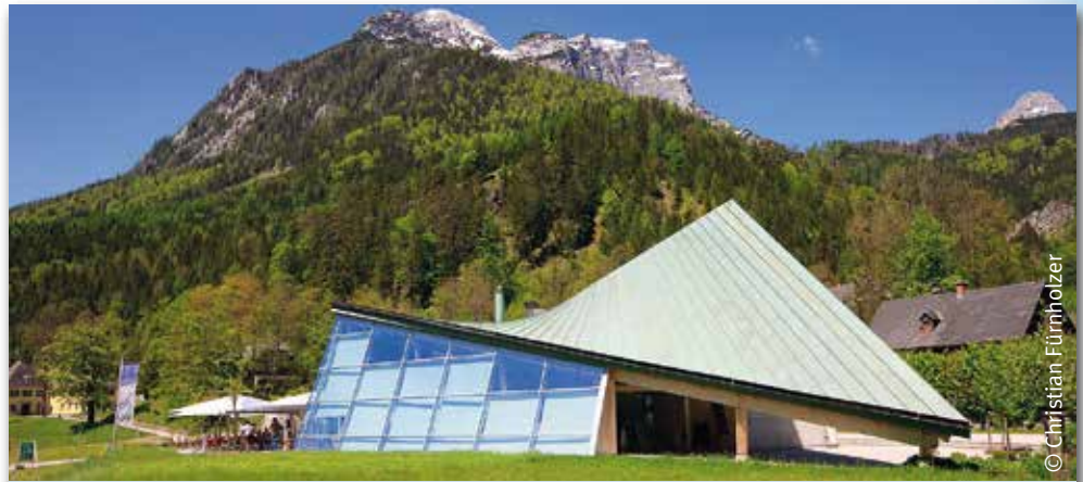
Nationalpark Pavillon in Gstatterboden
