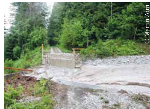
Zwischen zwei Straßenästen klappt eine 14 m lange Lücke über den Rotgraben
